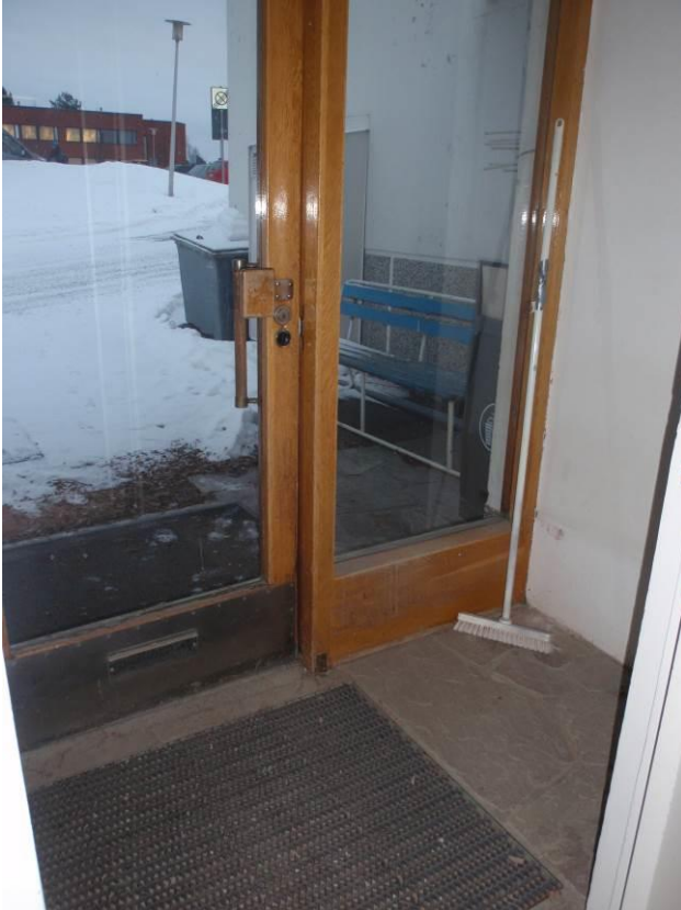
Sisäänkäynti: liuskekilvillattia ja alkuperäiset ovet
