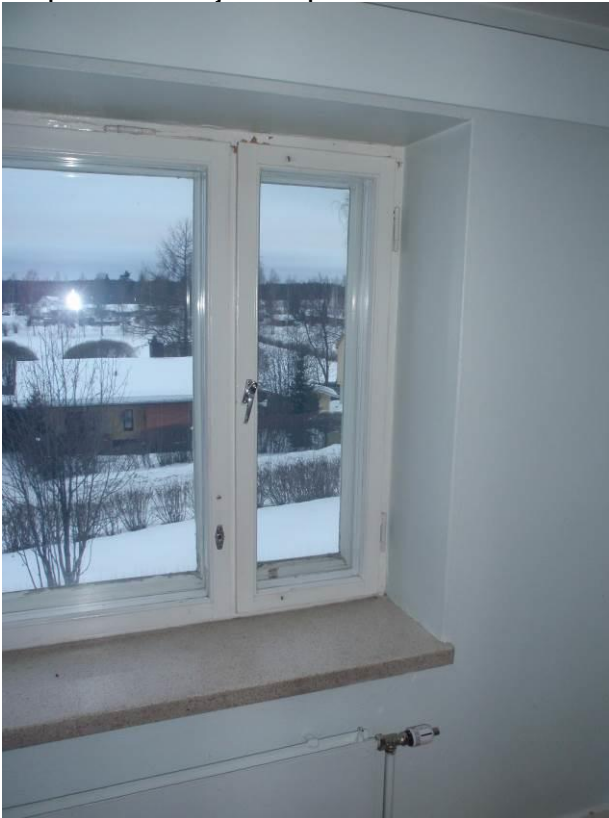
Alkuperäiset ikkunat ja ikkunapenkit
