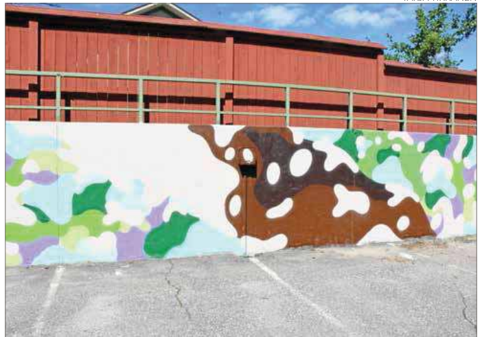
Harmaa betoniseinä alkaa pikkukihlajaa kadota.
