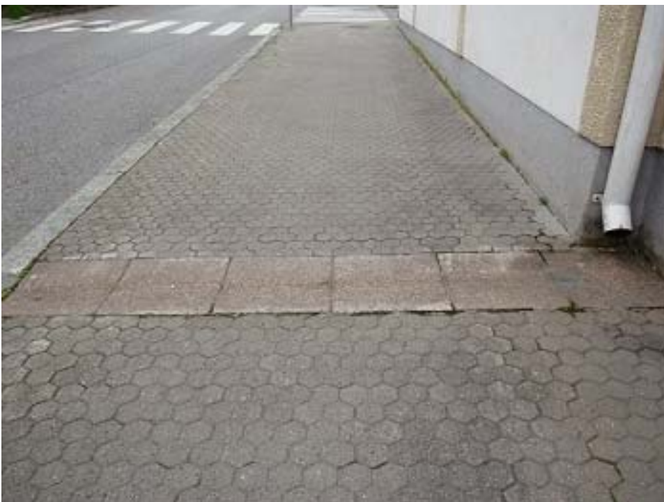
Kuva 20. Kyllikinkadulla sijaitsevat sadevesikourut koettiin turvallisuutta lisääviksi, koska ne ohjaavat sadevedet pois kaduilta, estäen näin tulvinnan ja lätäköiden syntymisen.
