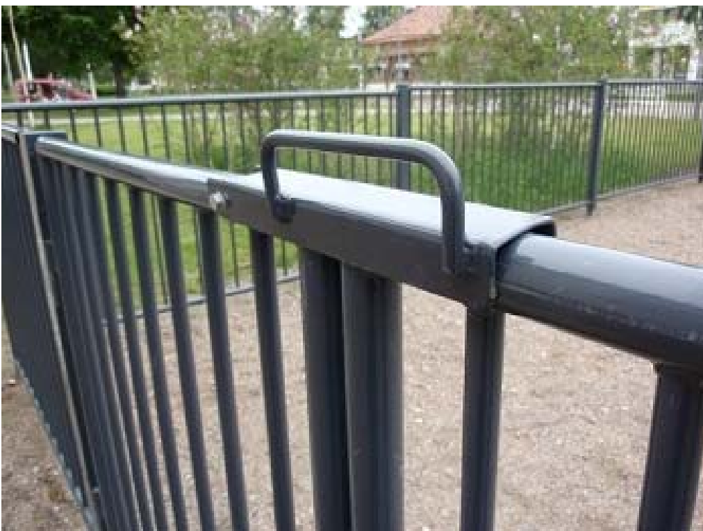
Kuva 16. Kirkkopuistonk adulla sijaitsevassa leikkikentässä porttien kahvat on sijoitettu lasten ulottumattomii n, mikä lisää leikkipaikan turvallisuutta
