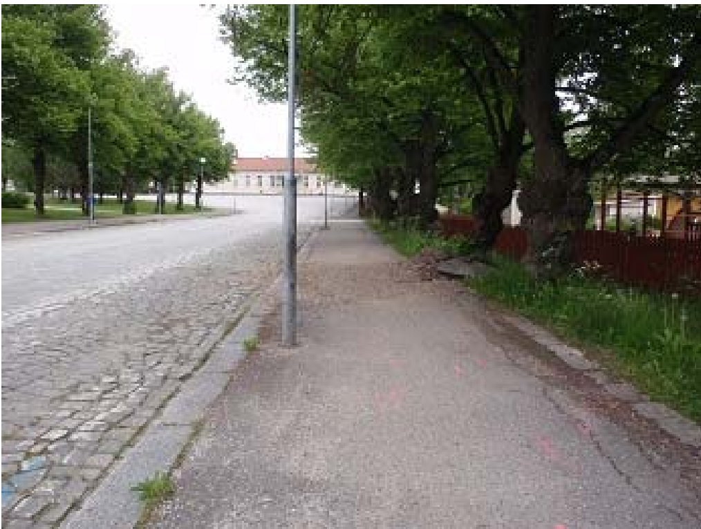
Kuva 42. Savonkadulla, juna-asemalle mentäessä, sijaitsevaa tietyömaata ei ole merkitty, eikä huonokuntoista kadunkohtaa ole kunnostettu.
