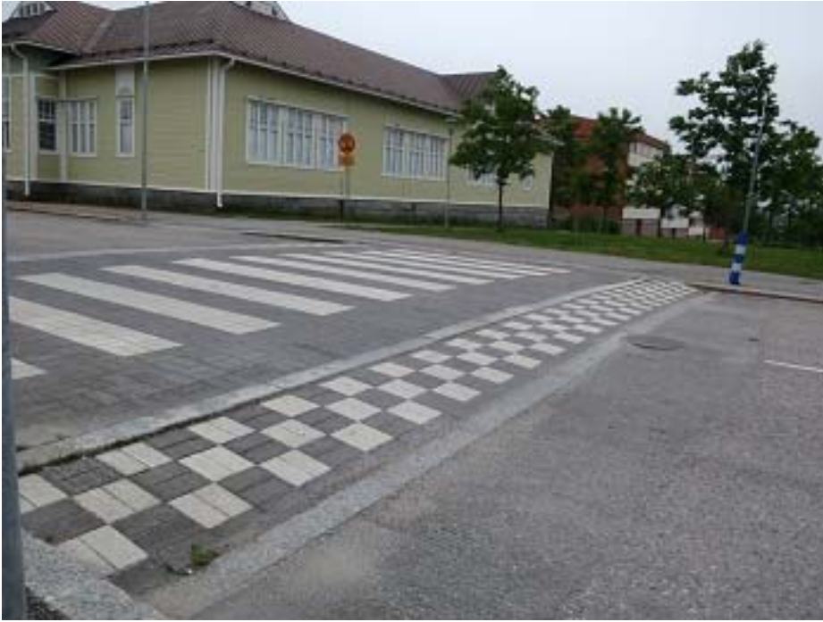
Kuva 41. Savonkadulla Edvin Laineen koulun ja Lyseon välissä sijaitseva iso hidastetyssä koettiin turvallisuutta lisääväksi.
