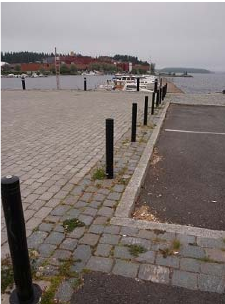
Kuva 36. Satamatorilla sijaitsevat reunapylväät koettiin turvallisuutta lisääviksi, sillä ne muun muassa eristävät alueen selvästi autoilta.
